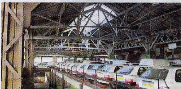
■ Une charpente métallique imposante. Photo archives Philippe Juste
