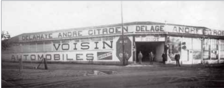
La façade du garage avec ses différentes enseignes en 1924, année où Pierre Gigot en devient le propriétaire. La RN10 n'est pas encore asphaltée.
